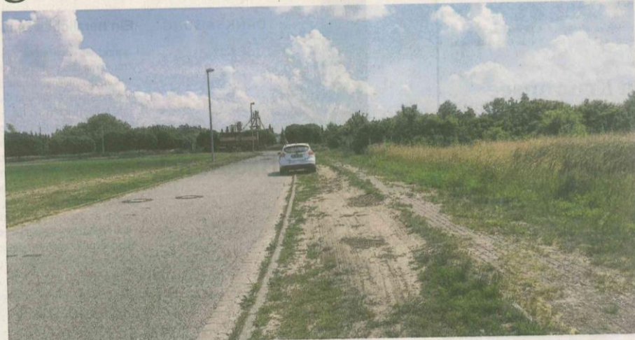
Im Woldegker Gewerbegebiet gibt es immer wieder Zerstörungen an den Banketten und Gehwegen durch illegal parkende Fahrzeuge. Der Laster im Hintergrund parkt allerdings richtig. Dort darf er stehen.
